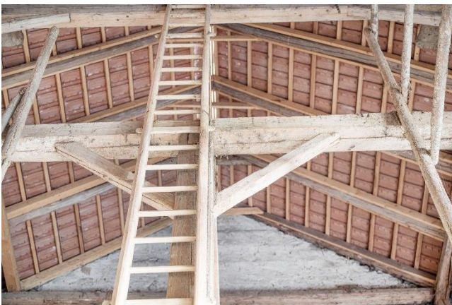
Blick zum neuen Dach über Oekonomieteil
