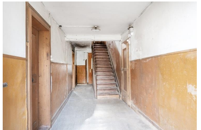
Eingang, links Türe zur Stube / Treppe zum OG
